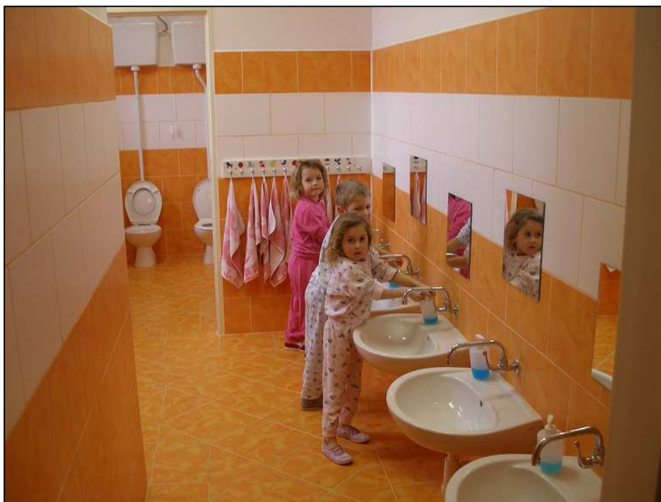
Umývárna mateřské školy po rekonstrukci
